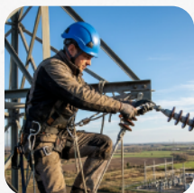
Trabajos eléctricos en altura
