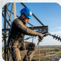
Trabajos eléctricos en altura
