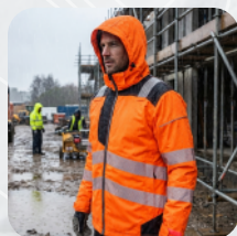
Trabajos de construcción
