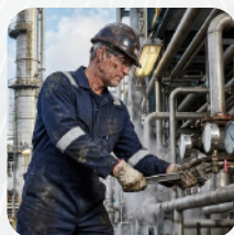
Montaje y mantenimiento
